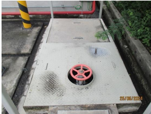
รูปที่ 3-29 ป่อ (Sump) สำหรับรวบรวมสารเคมี ที่อาจหกรั่วไหล
