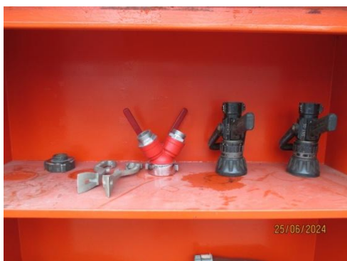
รูปที่ 3-55 Firewater Nozzle
