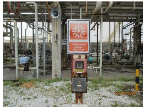
รูปที่ 3-52 Fire Alarm Manual System
