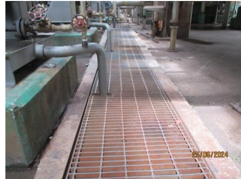
รูปที่ 3-79 รางระบายน้ำเสียของโครงการ
