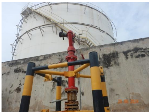
รูปที่ 3-53 หัวจ่ายน้ำดับเพลิง (Fire Water Hydrant) บริเวณลานถังเก็บกัก
