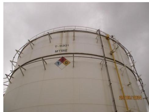
รูปที่ 3-44 ระบบโปรยน้ำดับเพลิง (Fire Water Sprinkle) สำหรับดับเพลิงและหอกลิ้น
