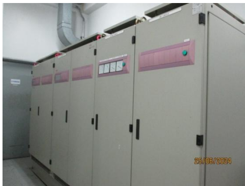
รูปที่ 3-60 ระบบไฟสำรองแบบยูพีเอส (UPS)
