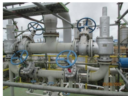
รูปที่ 3-69 วาล์วระบายความดัน (Pressure Relief Valve) ที่ถังเก็บกัก
